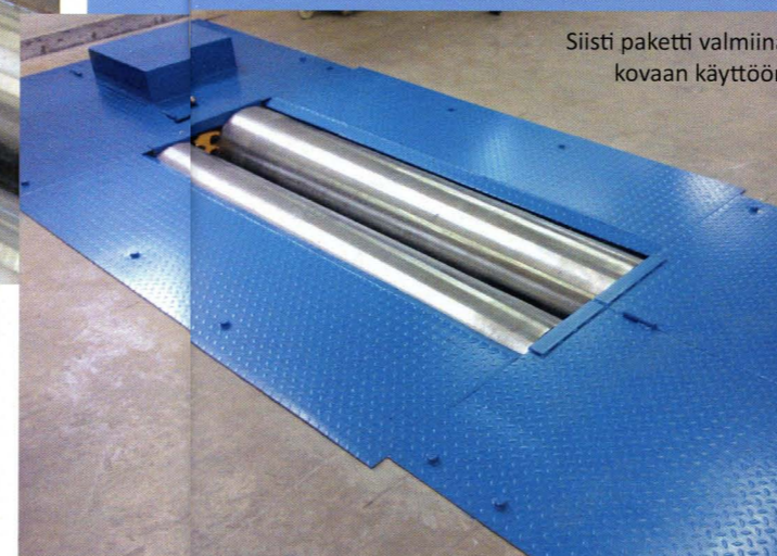
Kokonaisuus valmiina ennen suoja- ja ajolevyjä
