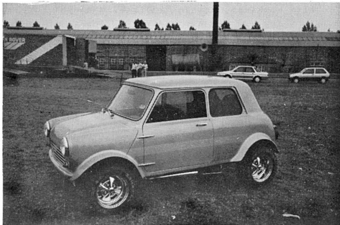
GRP muovikorinen Mini 60-luvulta "Hieman" customoitu Mini. Voimalaitteena Fordin V8
