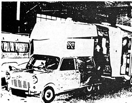
VARSIN katevän näköinen yhdistelmä on tämä "Mini Composite" nimen saanut asunovaunu. BMC Minin pakettiautoversion on pieniin muutoksiin valmis ottamaan peränsä täydellisen asunovaunun ja katolivan kevyen lasikultajollan. Kuten Miniaakin, on asunovaunussa käytetty hyväksi jokainen kuulosenttimetri. Laite esiteltiin keuhkailuilla Lontoossa.
