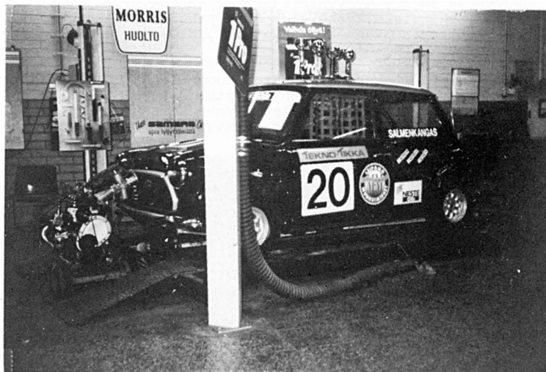
Numero 18 oli Mini Cup:n rata-auto, hevosvoimia 100, kuu- tiotilavuutta 1000ccm. Autolla on voitettu jääratamestaruus - 95 ja sen omistaa Jukka Salmenkangas. Auton on rakentanut myyminen Mini Racing Team Giant Killers, ketä kaikkia nimen taakse sitten kätkeytyykään.
