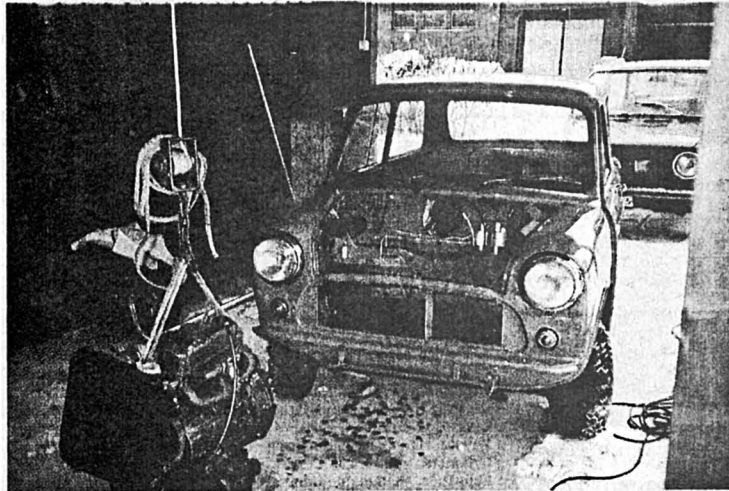
Entisöinti kesti pari vuotta. Tässä auton kori on jo loppusilausta vailla ja vieressä näkyvä moottorin kasassa.
